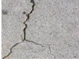
Una elevación o caída de la grieta de la acera mayor a media pulgada. *Opciones de reparación: De 0 a 2 pulgadas se puede rectificar. Por encima de 2 pulgadas habría que reemplazarlas.*
